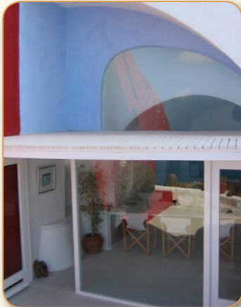
YIN betonter Eingang
